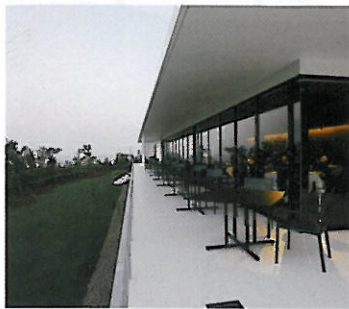
海辺の「レストラン無垢」からは、どこまでも続く水平線を眺めながら優雅に食事ができる
